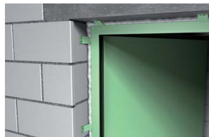
Foaming steel door frames
